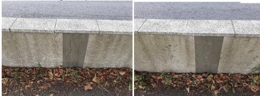
*Toiles d’armature et fissures verticales sur les murets béton du SE – SMLCI 02/2024*
