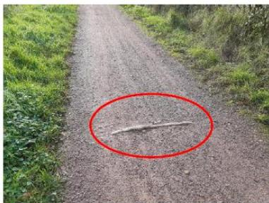
Figure 3-9 : Développement racinaire dans le corps de digue
