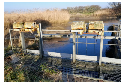
Ouvrage à Périers-en-Auge—NCPA 2025 ©
